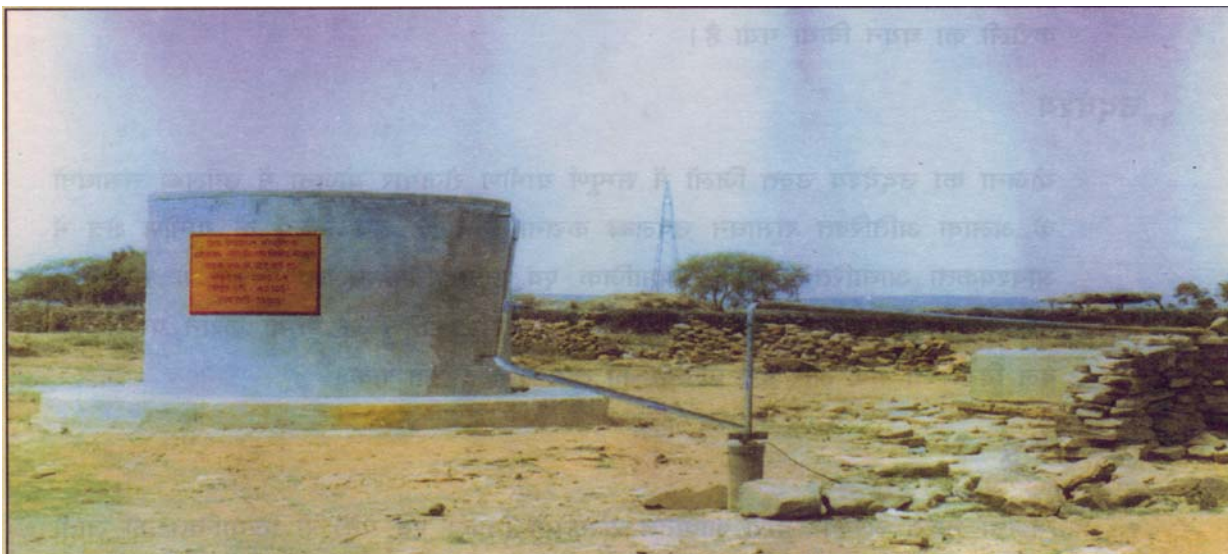
सम्पूर्ण ग्रामीण रोजगार योजना के तहत ग्राम पंचायत मांदलिया, पंचायत समिति लाडपुरा, जिला कोटा में पानी की टंकी का निर्माण
